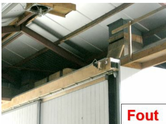
Afbeelding: Bij bovenstaande 1e afbeelding ontbreekt het hekwerk vrijwel volledig. Dit is dan ook fout.
