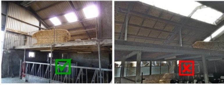
Foto Zolder met afscherming en open zolder
