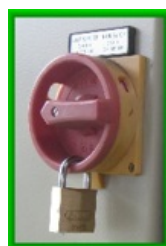
Afbeelding: vergrendelde hoofdschakelaar
