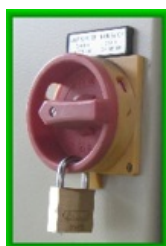
Afbeelding: vergrendelde hoofdschakelaar
