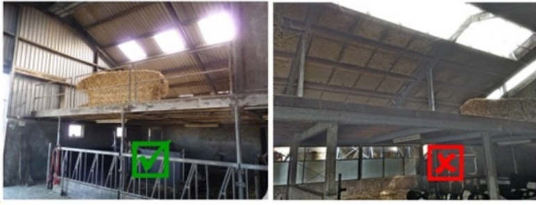
Foto Zolder met afscherming en open zolder
