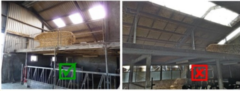
Foto Zolder met afscherming en open zolder
